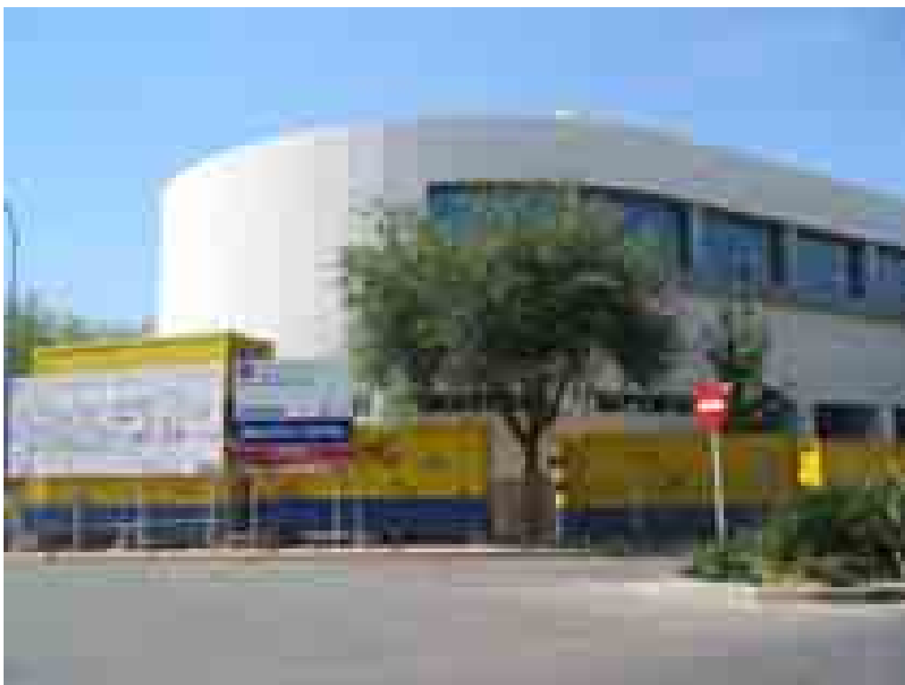
Fotografía 38: Construcción de la nueva Biblioteca Central en Pza Andrés Caballero.
