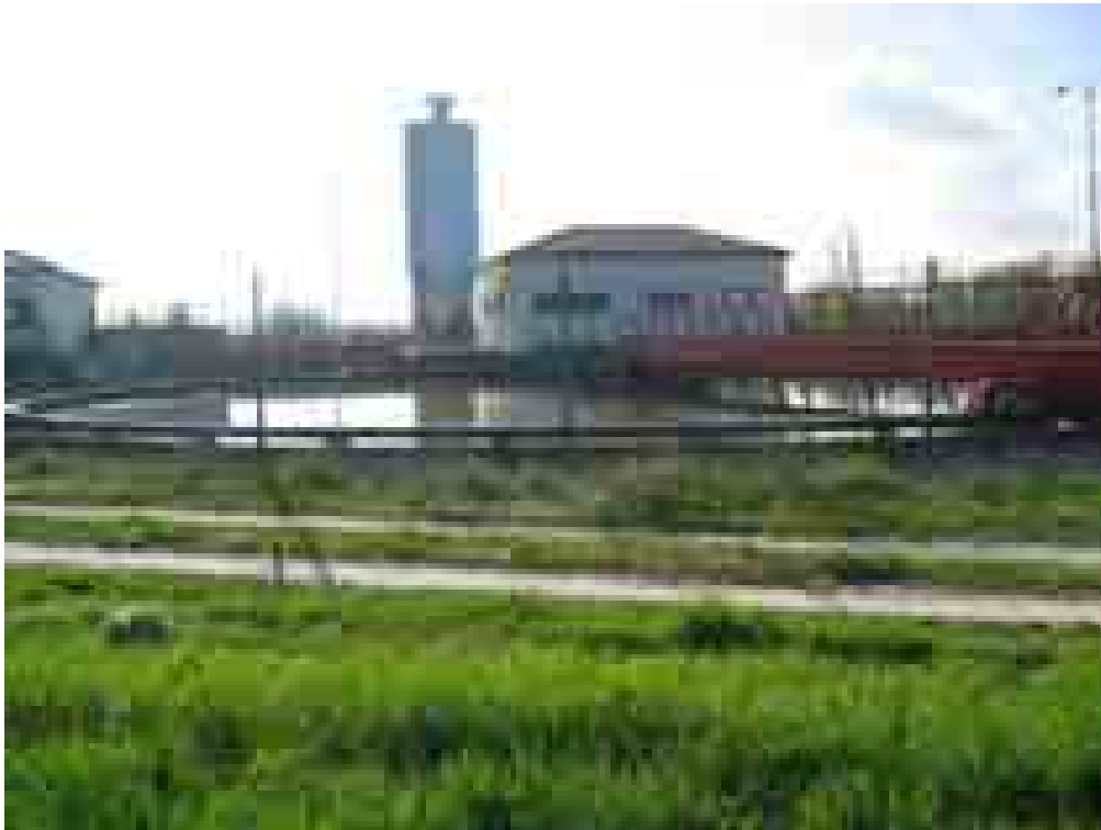
Fotografía 18: Depuradora del Arroyo de la Vega.
