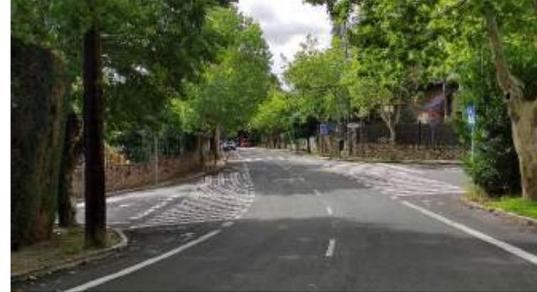
Ilustración 102. Ampliación de acera con señalización horizontal en Fuente del Fresno.
