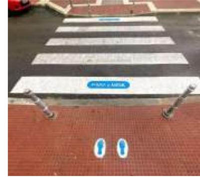
Ilustración 27. Señalización horizontal mediante pintura de los caminos escolares. Fuente: Crónica Norte.
