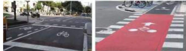
Ilustración 52. Ejemplos de señalización de “avanzabicis” y cruce ciclista.
