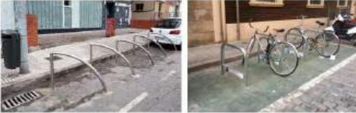
Ilustración 53. Sistema de anclajes en U. ....64
