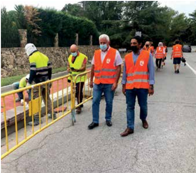
▲ El alcalde y el vicealcalde visitaron las obras.
